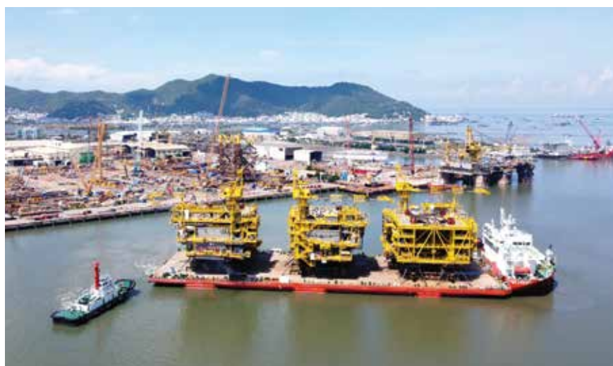
PTSC M&C hạ thủy, vận chuyển và bàn giao cho NOC 3 giàn đầu giếng Dự án Gallaf - giai đoạn 1. Ảnh: PTSC
