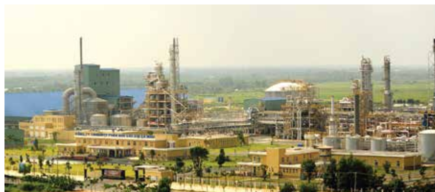
Nhà máy Đạm Cà Mau. Ảnh: PVCFC
